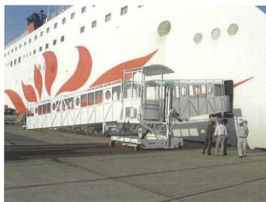
図-67 ボーディングブリッジの設置例 (志布志港)
